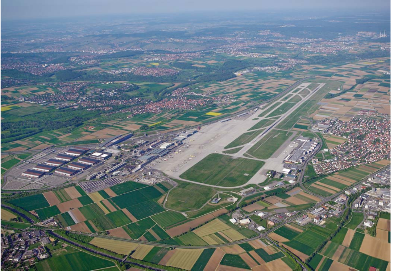
Bild 1 Flughafen Stuttgart GmbH
